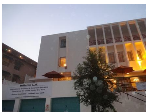
Westwood Hall 外観
